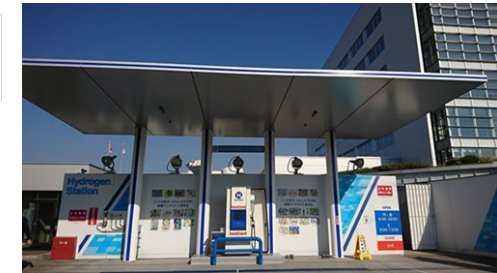
水素ステーション
